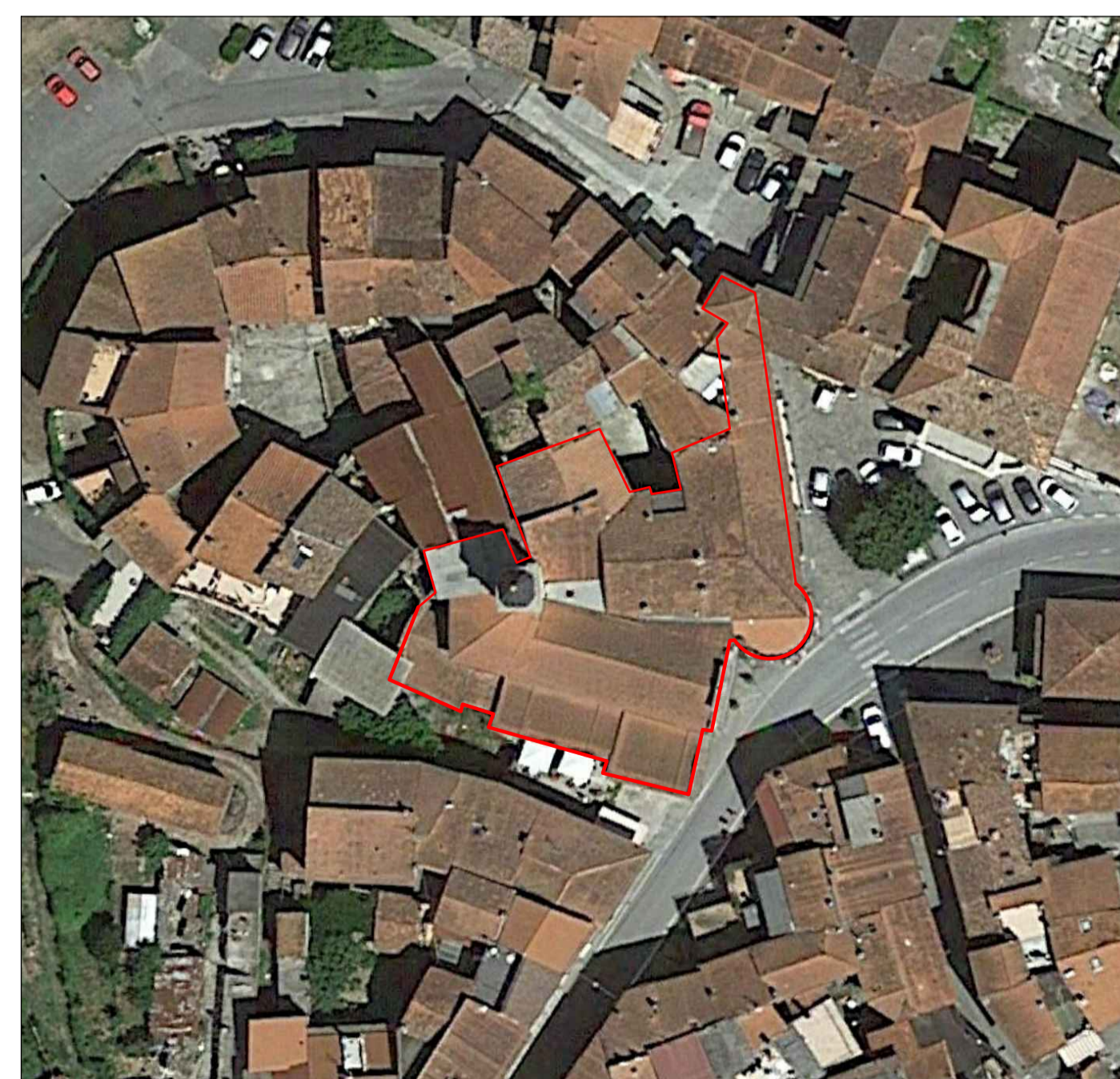
VISTA AEREA DEL COMPLESSO PARROCCHIALE
