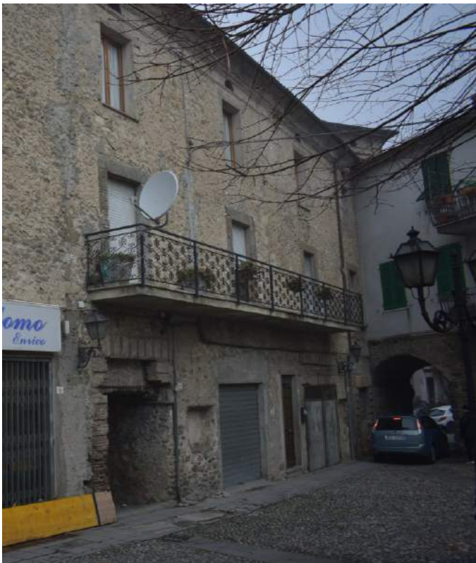
21. La facciata della canonica prospiciente piazza Castello da rigenerare nelle finiture e da ridefinire nelle aperture di piano terra così da riportarla all'aspetto originale.
