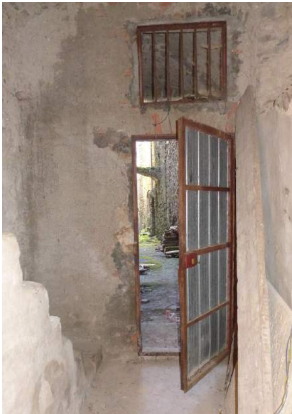
48-49. L'attuale separazione degli ambienti parrocchiali dal vicolo della canonica: la tramezza in mattoni e gli infissi metallici esistenti verranno demoliti realizzando una nuova apertura vetrata al limite esterno della volta a botte così da ricostituirne la continuità.
