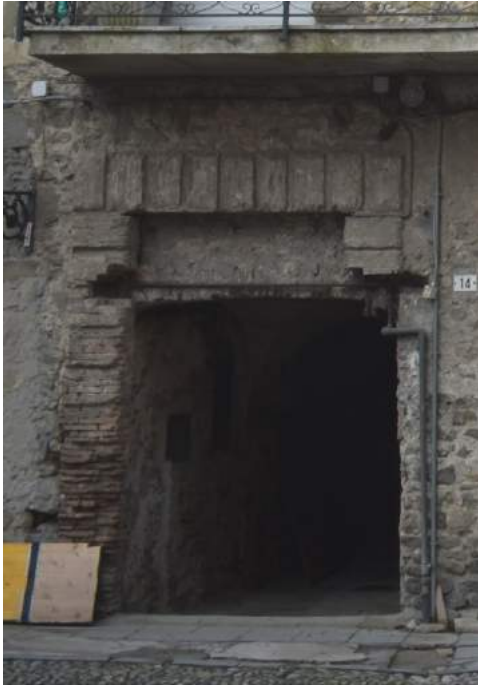
23. Il portale d'ingresso al cortile che verrà restaurato e diventerà l'ingresso principale al presepe e a tutto il complesso parrocchiale
