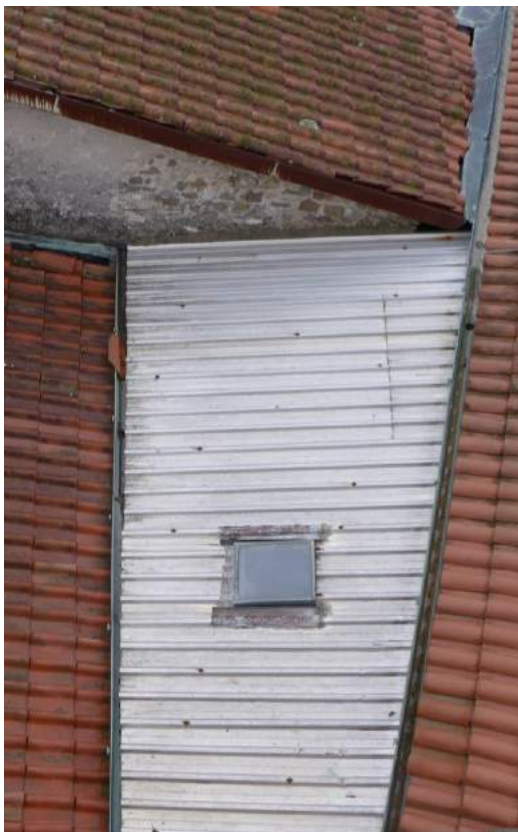
39. La copertura del vano scale C da sostituire con una nuova struttura costituita da elementi in vetro armato U-GLASS che restituisca agli ambienti l'originario aspetto di corte interna.
