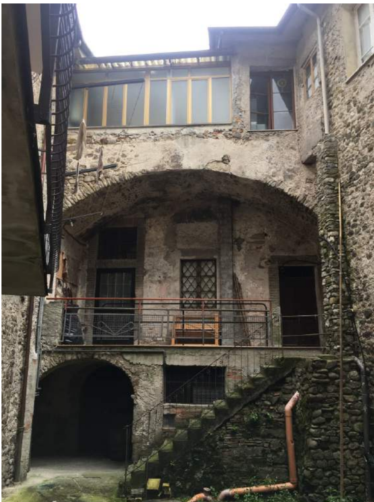
34. La facciata lato corte con la scala B che consentirà l'accesso principale al complesso parrocchiale: la facciata verrà rigenerata, verranno eliminate le superfetazioni come la veranda del secondo piano e il condotto dell'impianto termico e regolarizzate le canalizzazioni degli impianti fognari. La scala B, in cls di recente costruzione, sarà sostituita con una nuova i cui gradini avranno una pedata che consenta un comodo utilizzo.
