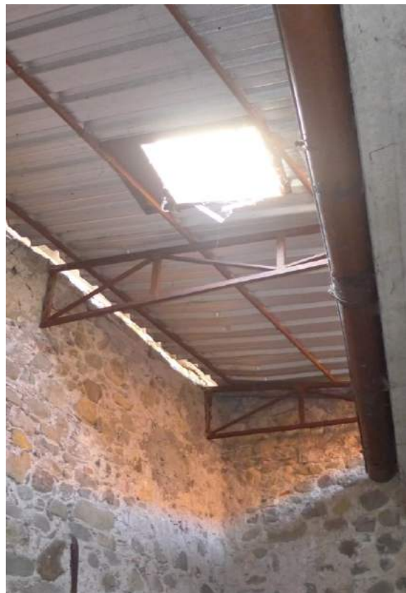
39. La copertura del vano scale C da sostituire con una nuova struttura costituita da elementi in vetro armato U-GLASS che restituisca agli ambienti l'originario aspetto di corte interna.
