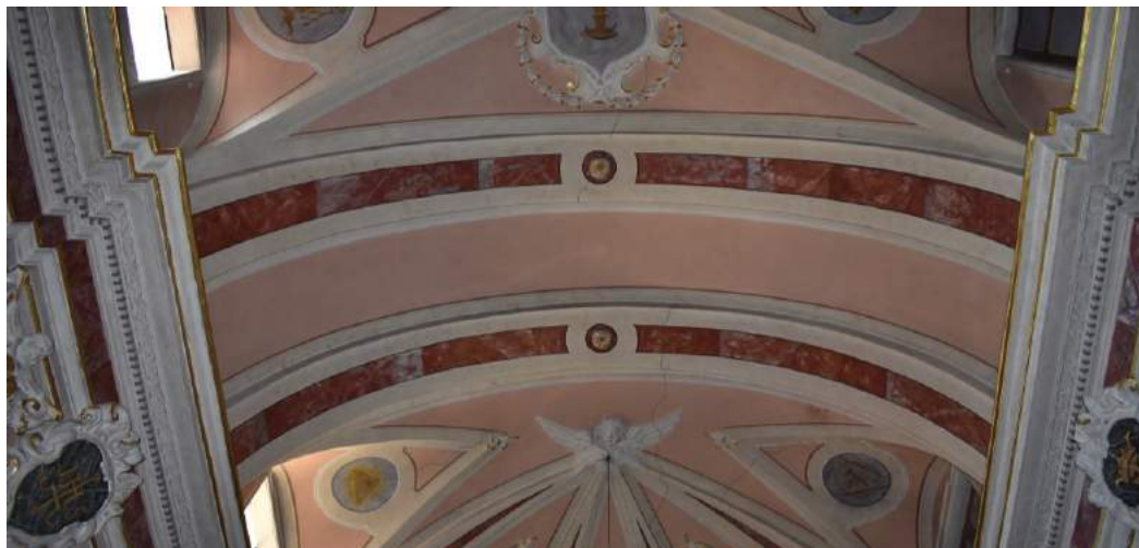
9. Le lesioni dei due archi del presbiterio in corrispondenza della quale si inseriranno le catene C1 e C2.
