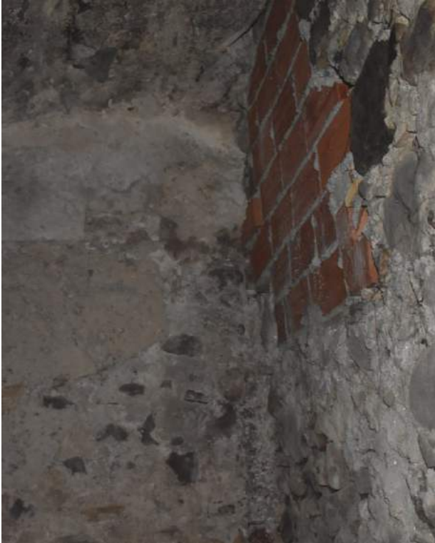
40. La partenza della nuova scala D nel punto al PT in cui è stato realizzato un riporto chiaramente testimoniato dalla volta che proseguiva intonacata.
