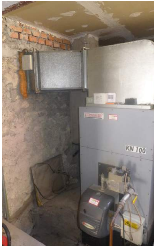
18. La centrale termica da smantellare.
