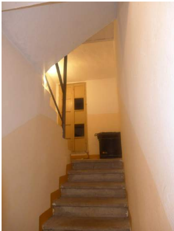
28-29. Il vano scale A, realizzato negli anni '70, che verrà demolito per far posto alla ridefinizione del nuovo vano scale, con ascensore, che consentirà di rendere accessibili quasi tutti i locali del complesso architettonico senza barriere architettoniche.
