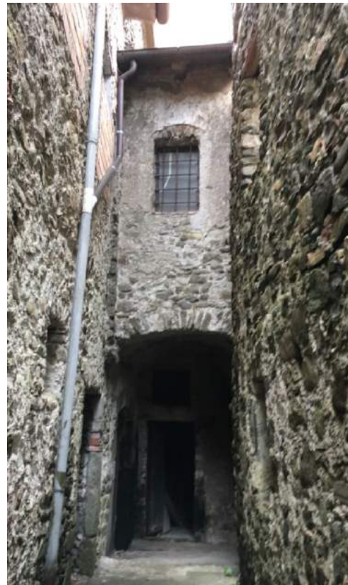
48-49. L'attuale separazione degli ambienti parrocchiali dal vicolo della canonica: la tramezza in mattoni e gli infissi metallici esistenti verranno demoliti realizzando una nuova apertura vetrata al limite esterno della volta a botte così da ricostituirne la continuità.
