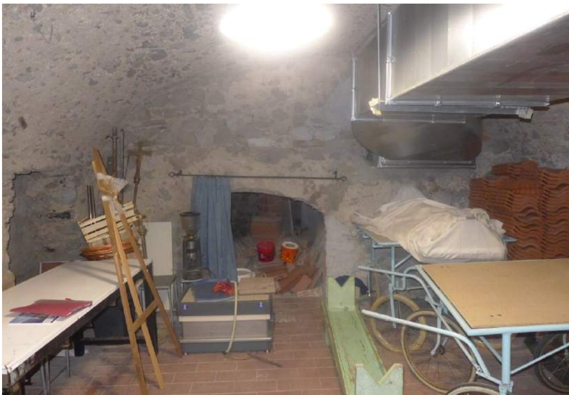
19. La sala di piano terra dalla quale verrà rimosso il condotto di aereazione così da renderla un ambiente di pregio nel quale esporre tramite un adeguato allestimento le trasformazioni architettoniche che il castello di Pallerone ha subito nei secoli. Sul fondo del locale sbarcherà la scala D che consentirà il collegamento diretto con la chiesa.
