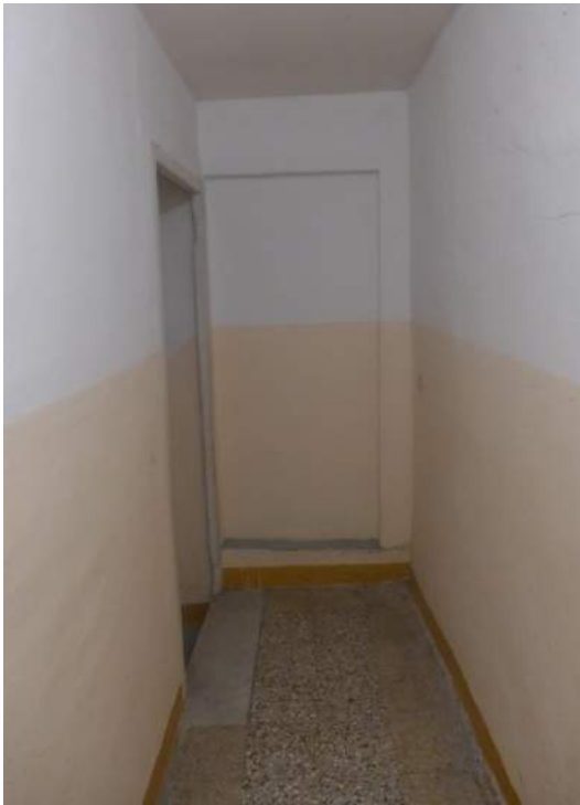
30. Il tamponamento del collegamento tra le stanze delle associazioni e le sale parrocchiali che verranno rimesse in comunicazione dalla nuova impostazione del vano scala A.
