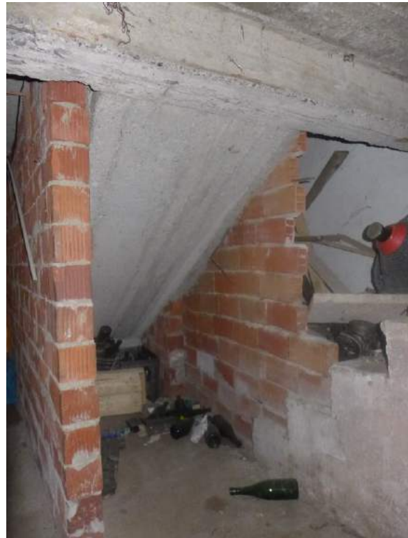
27. Il sottoscala del recente vano scale (scala A) che sarà ridefinito.
