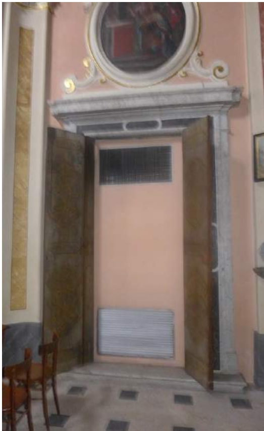
17. La parte terminale del condotto per il riscaldamento della chiesa.
