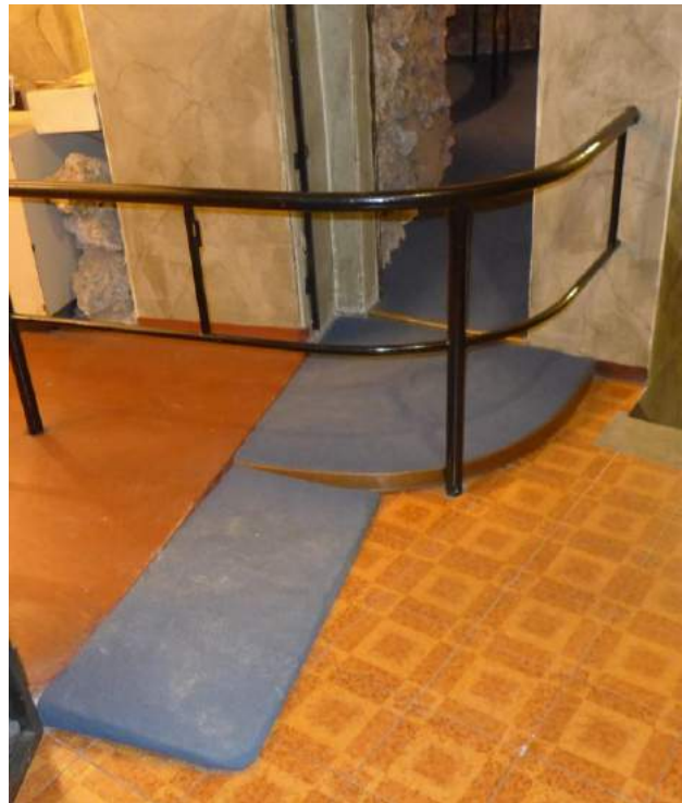
43. L'attuale gestione delle entrate al presepe e dei dislivelli del pavimento. L'ingresso verrà allargato e il pavimento del disimpegno sarà riportato allo stesso livello del presepe e della sala introduttiva.
