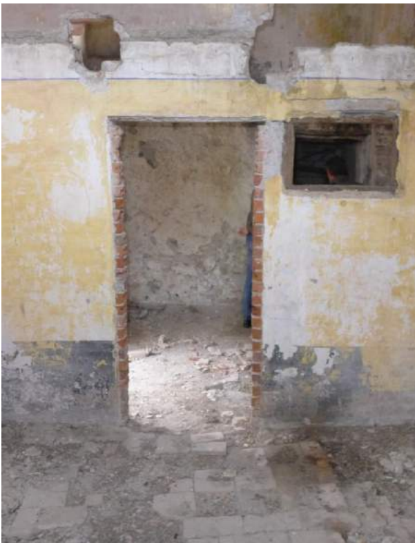
45. La precaria tramezzatura dell'unità abitativa da demolire in occasione dei lavori di ristrutturazione volti a riportare i locali alla loro funzione originaria.
