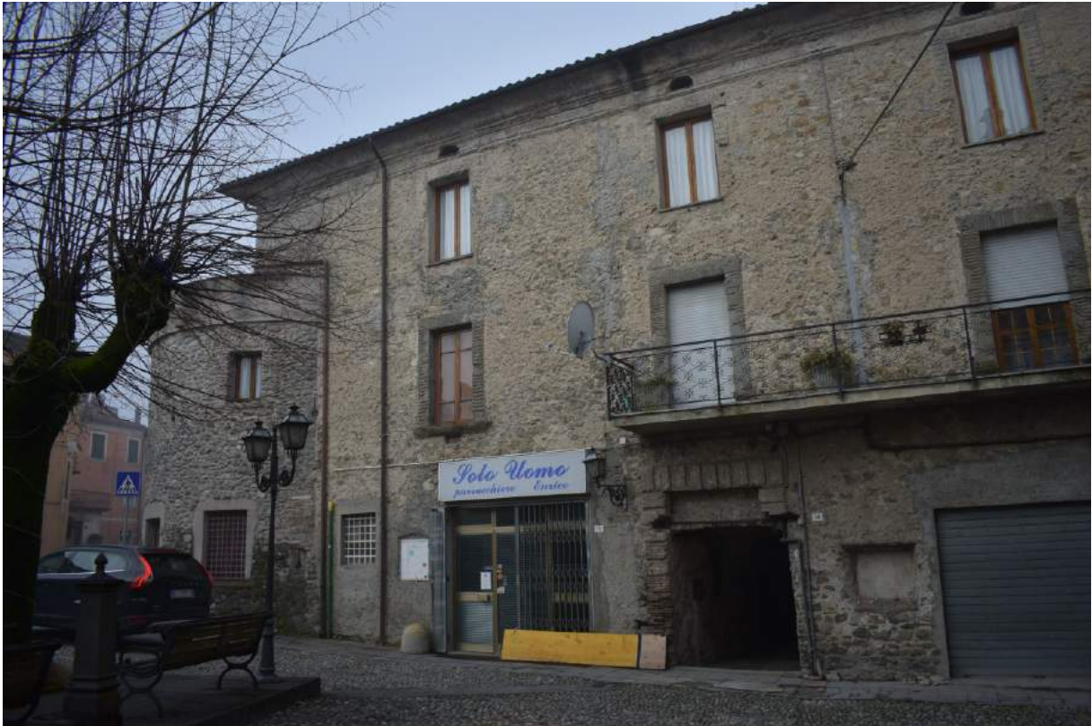
20. La facciata della canonica prospiciente piazza Castello da rigenerare nelle finiture e da ridefinire nelle aperture di piano terra così da riportarla all'aspetto originale.
